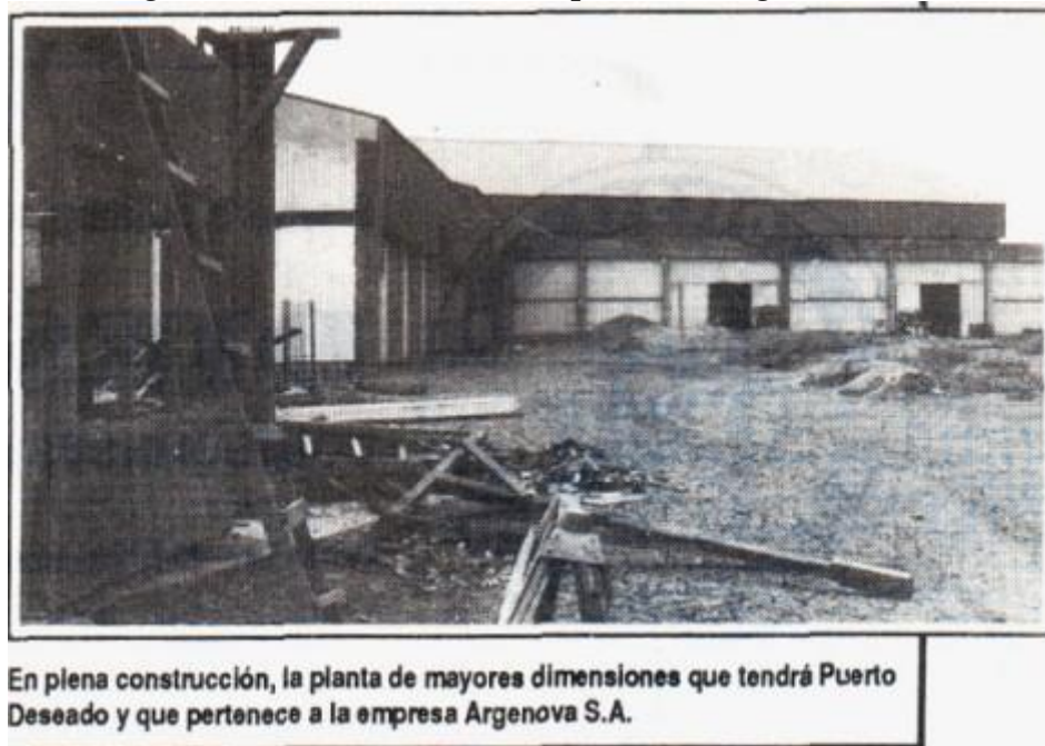
Figura 4. La construcción de la planta de Argenova S.A. 17
