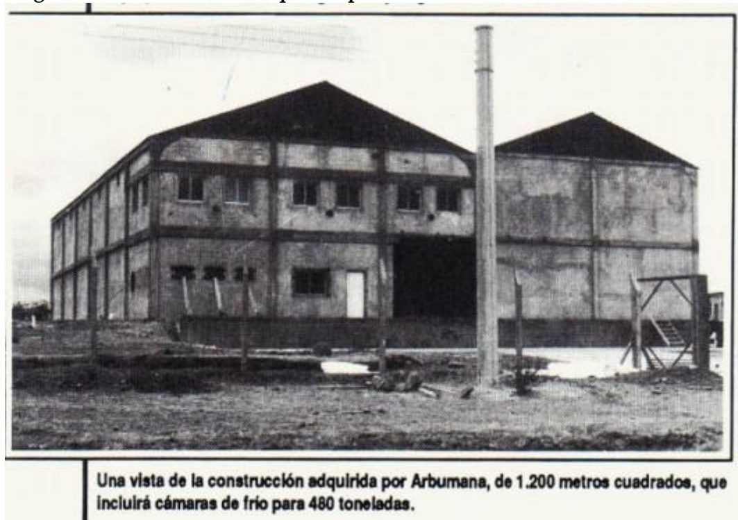
Figura 5. La construcción adquirida por Arbumasa de 1200 metros cuadrados 18
