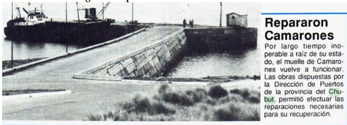
Figura 6. Reparación del muelle de Camarones. 29
