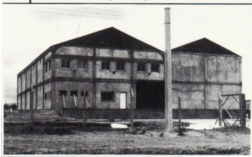
Figura 5. La construcción adquirida por Arbumasa de 1200 metros cuadrados 18
