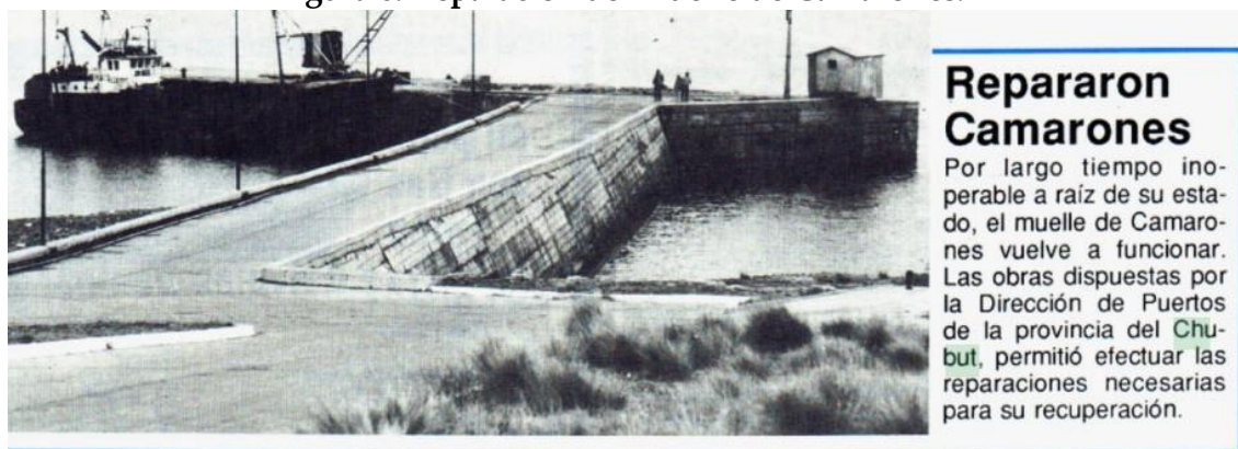
Figura 6. Reparación del muelle de Camarones. 29
