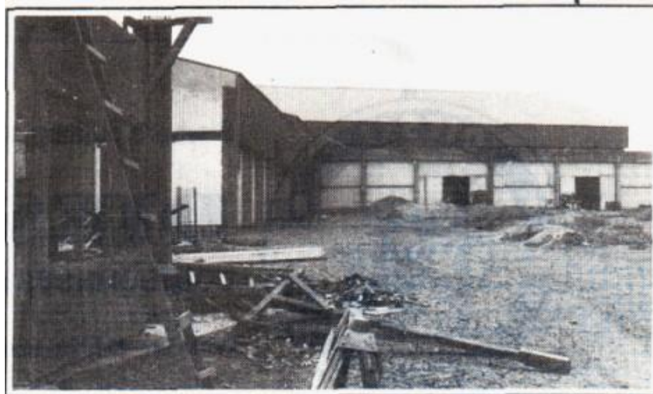
Figura 4. La construcción de la planta de Argenova S.A. 17
